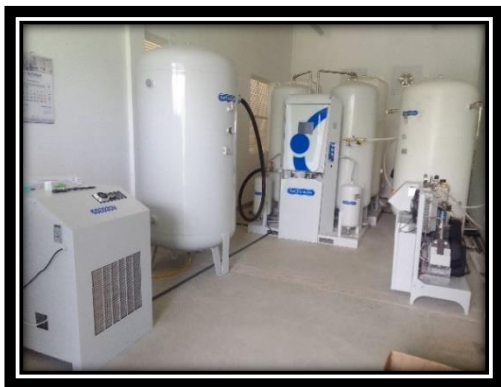
තෙල්දෙනිය මූලික රෝහලේ ඔක්ෂිජන් නිපදවීමේ පද්ධතිය (OXYGEN CONCENTRATOR PLANT)
