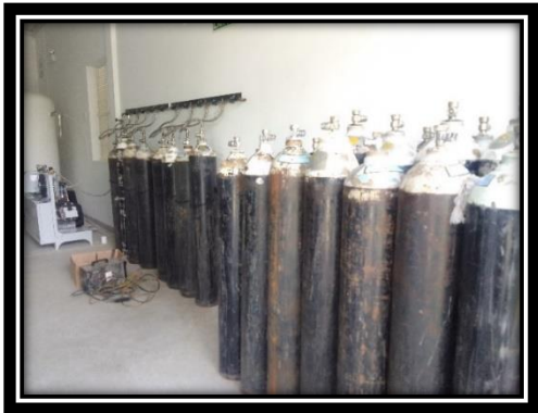
තෙල්දෙනිය මූලික රෝහලේ ශල්‍යාගාරය හා දැඩිසත්කාර ඒකකය සඳහා දිවෙන Wall Oxygen පද්ධතිය සඳහා ද ඔක්ෂිජන් සැපයෙන්නේ මෙමගිනි.
