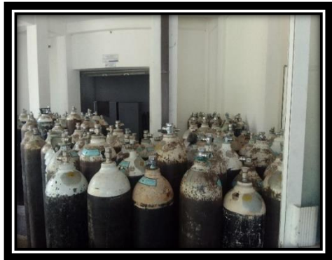
තෙල්දෙනිය මූලික රෝහලේ ශල්‍යාගාරය හා දැඩිසත්කාර ඒකකය සඳහා දිවෙන Wall Oxygen පද්ධතිය සඳහා ද ඔක්ෂිජන් සැපයෙන්නේ මෙමගිනි.
