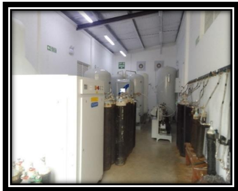
දික්ඔය මූලික රෝහලේ ඔක්ෂිජන් නිපදවීමේ පද්ධතිය (OXYGEN CONCENTRATOR PLANT)
